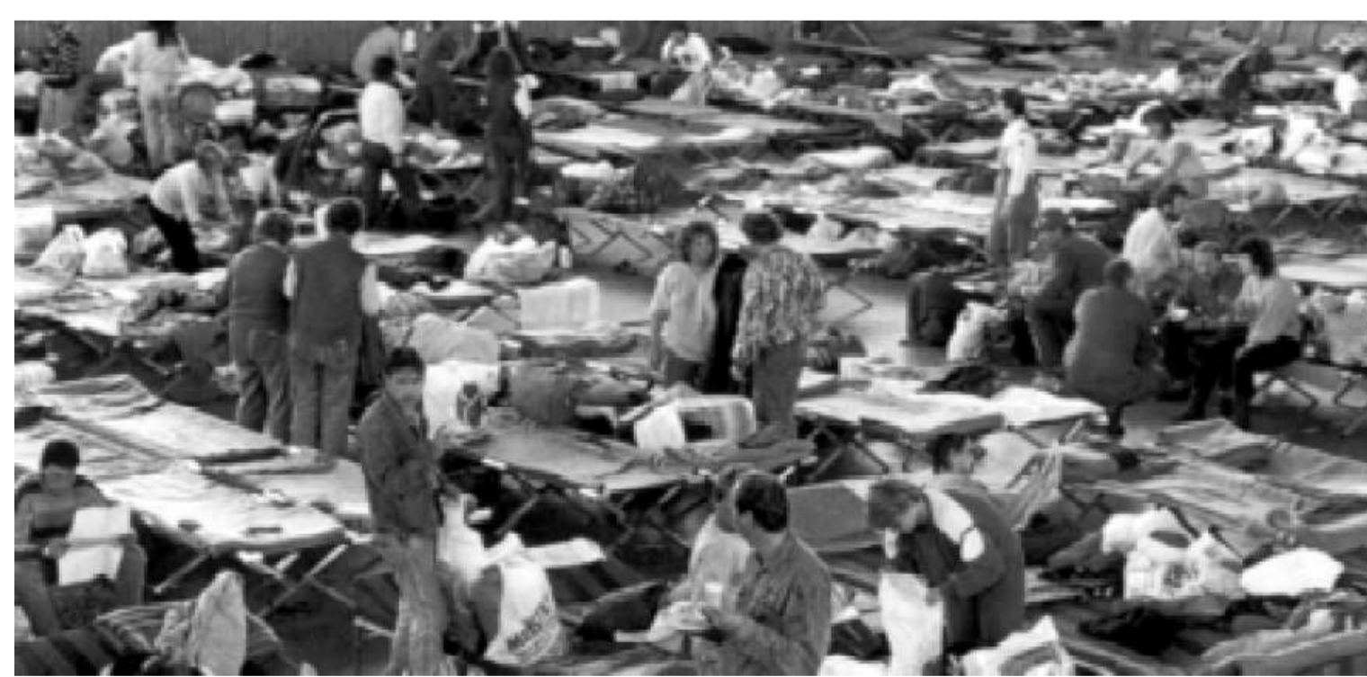
Zehntausende verlassen im Sommer '89 die DDR Richtung Westen, auch wenn es dort zunächst nur überfüllte Aufnahmelager für sie gibt
